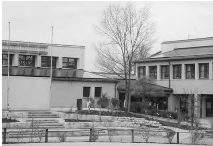
Die neue Photovoltaik-Anlage der Schule, in Betrieb seit Januar 2021. Sie erreicht 89 kWp und produziert 25.000 kWh/a zum Eigenverbrauch.
