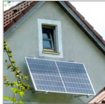
Ob im Garten, auf der Terrasse oder dem Balkon: So könnten PV-Kleinanlagen angebracht werden
